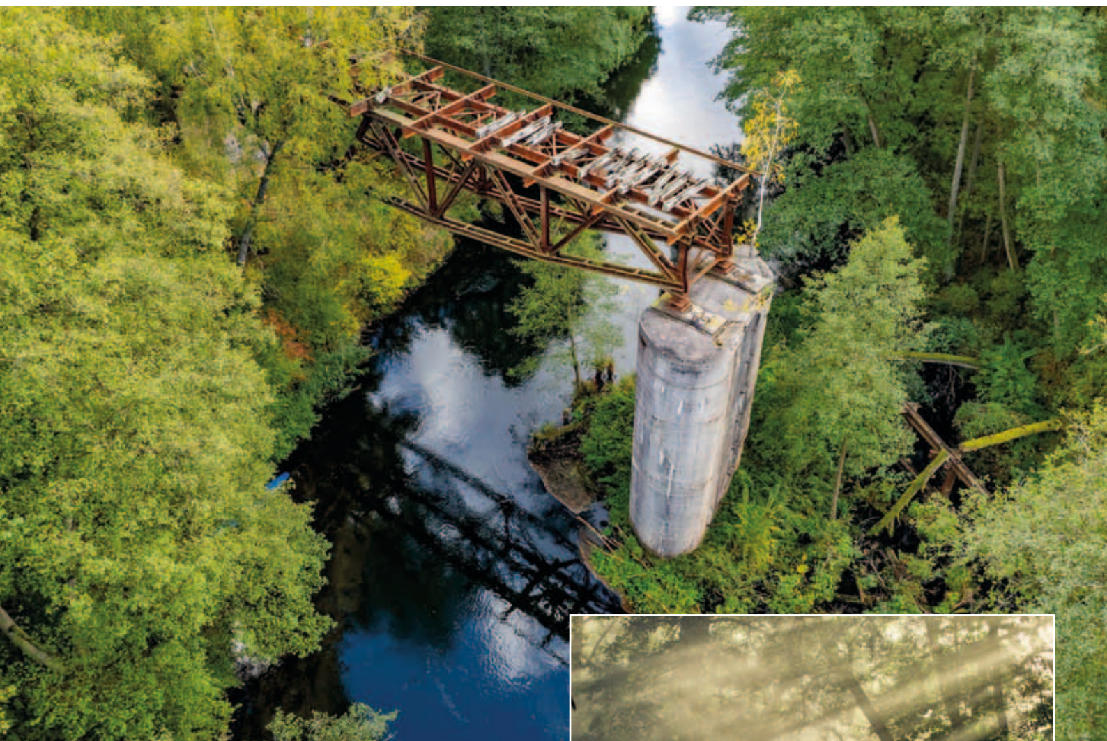
Gwda – pozostałości mostu kolejowego na trasie Wałcz – Złotów, fot. K. Bogdanowicz
