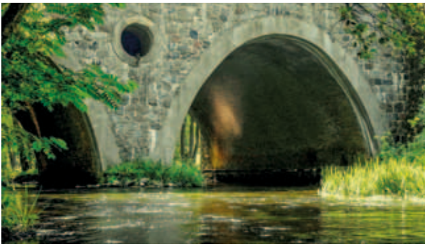
Nieczynny wiadukt na Piławie, fot. J. Ramucki
