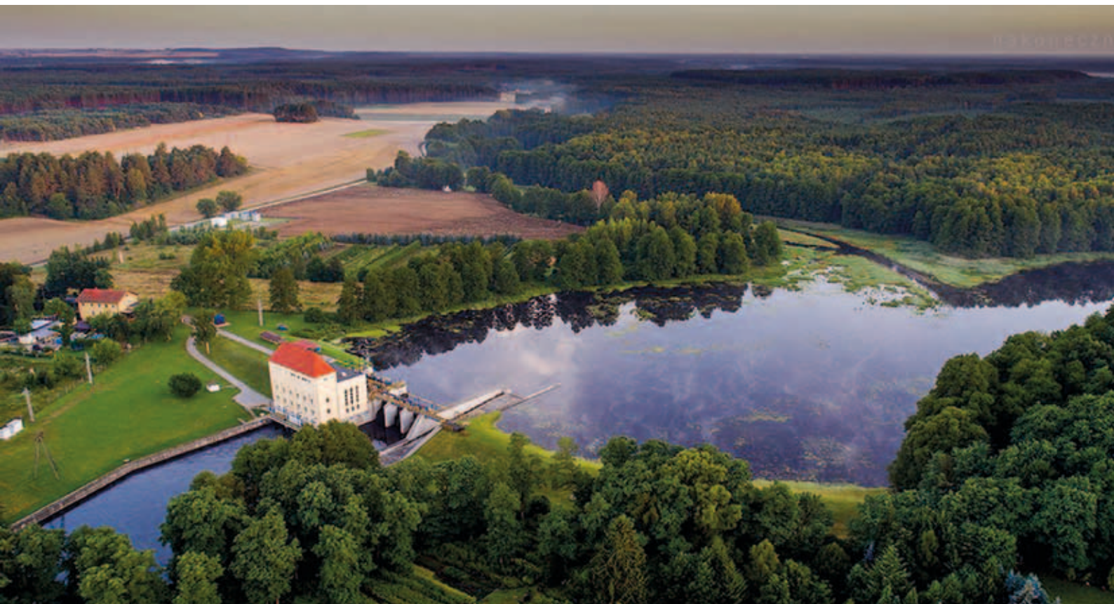
Elektrownia wodna w Dobrzycy, fot. S. Nakoneczny
