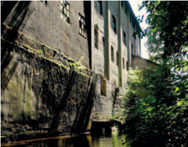
Budynki zakładu Mineral przy parku kajakowym Krępsko, fot. T. Wiesiołek
