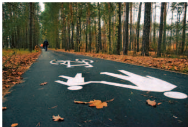
Ścieżka rowerowa na trasie Dolaszewo – Cyk, fot. UG Szydłowo
