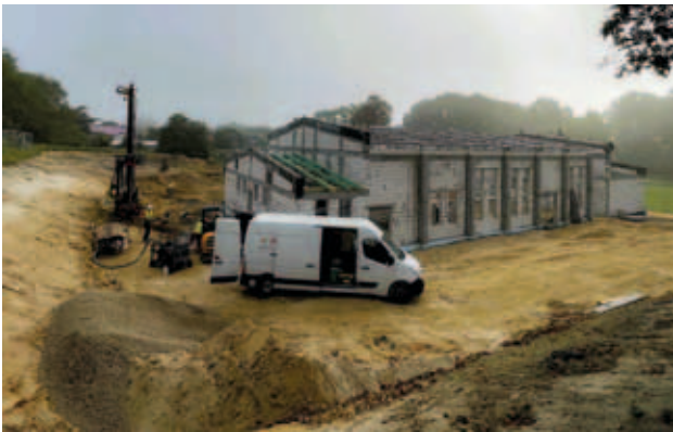
Park Stara Łubianka, filia Centrum Upowszechniania Kultury w trakcie budowy, fot. T. Wiesiołek
